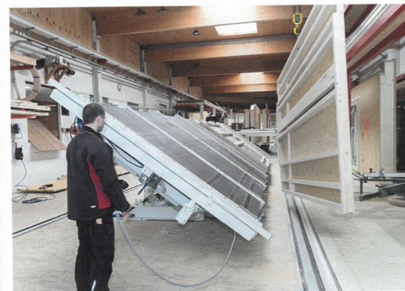
◄ Wenden der Elemente mit Aufstelltisch und Kran
