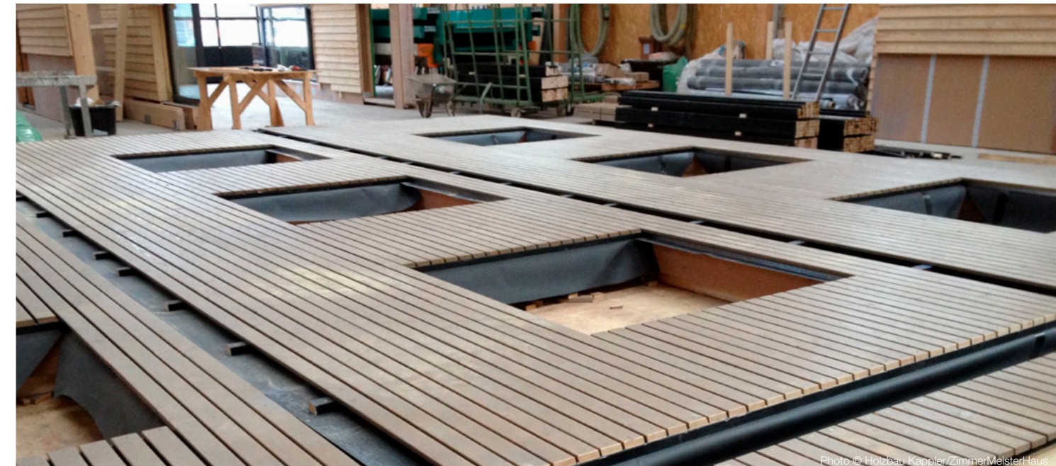
Photo © Holzbau Kappler/ZimmerMeisterHaus
