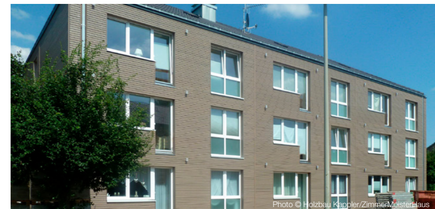
Photo © Holzbau Kappler/ZimmerMeisterHaus
