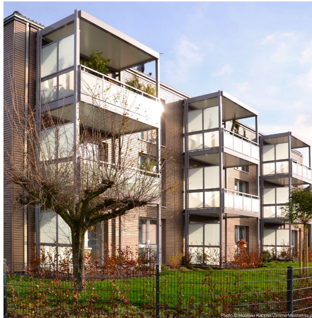
Photo © Holzbau Kappler/ZimmerMeisterHaus
