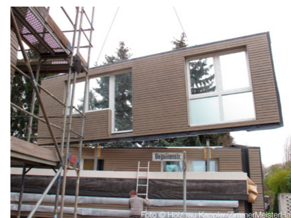
Foto © Holzbau Kappler/ZimmermeisterHaus
