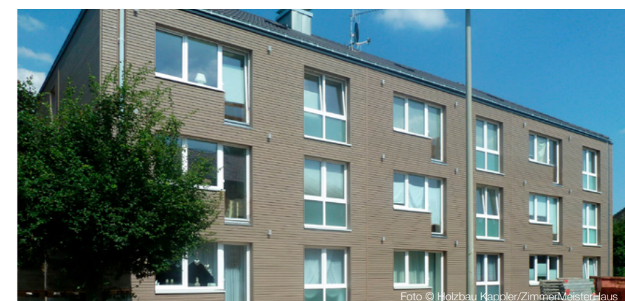
Foto © Holzbau Kappler/ZimmermeisterHaus
