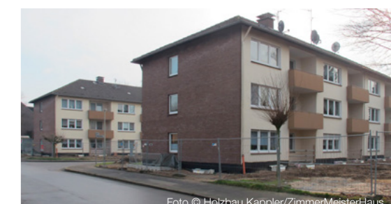
Foto © Holzbau Kappler/ZimmermeisterHaus
