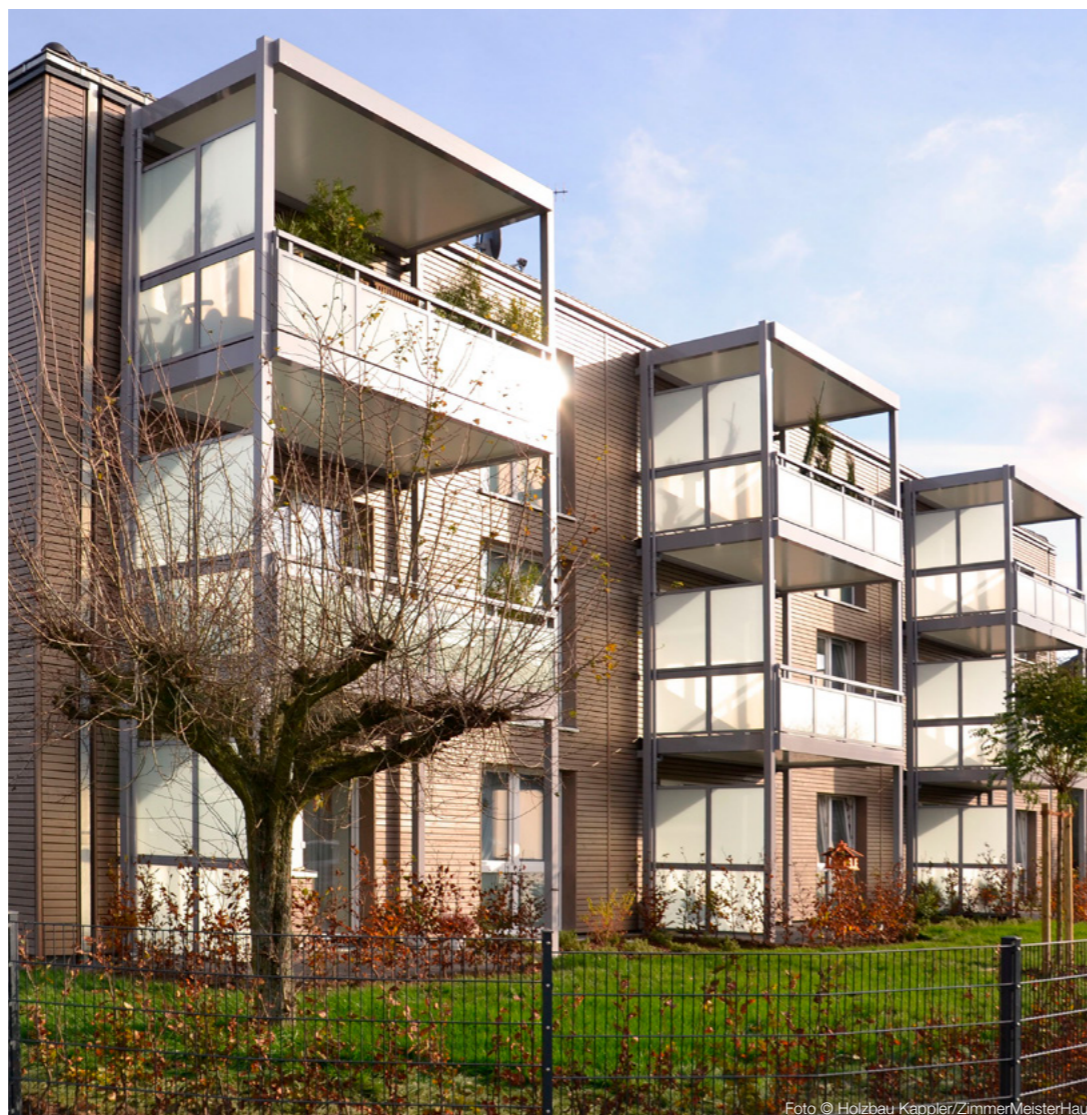
Foto © Holzbau Kappler/ZimmermeisterHaus
