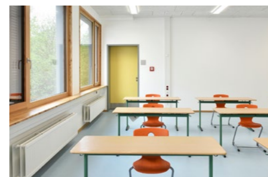
Photos : L'école Martin-Schule de Kempen a été construite en 2021 en l'espace de sept mois. Le bâtiment est équipé d'un système de ventilation central avec récupération de chaleur.
