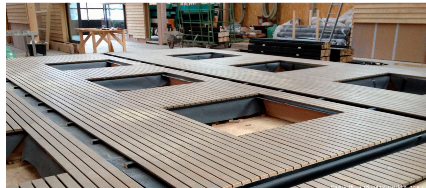
Photo © Holzbau Kappler/ZimmerMeisterHaus
