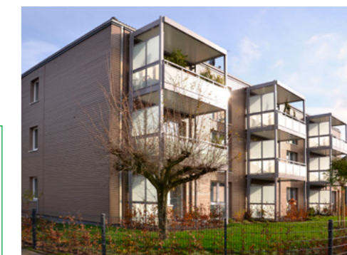
Photos : L'efficacité dans chaque détail : granIT vous guide à travers le processus de fabrication de votre construction à ossature bois avec une structure et un contrôle clairs.
