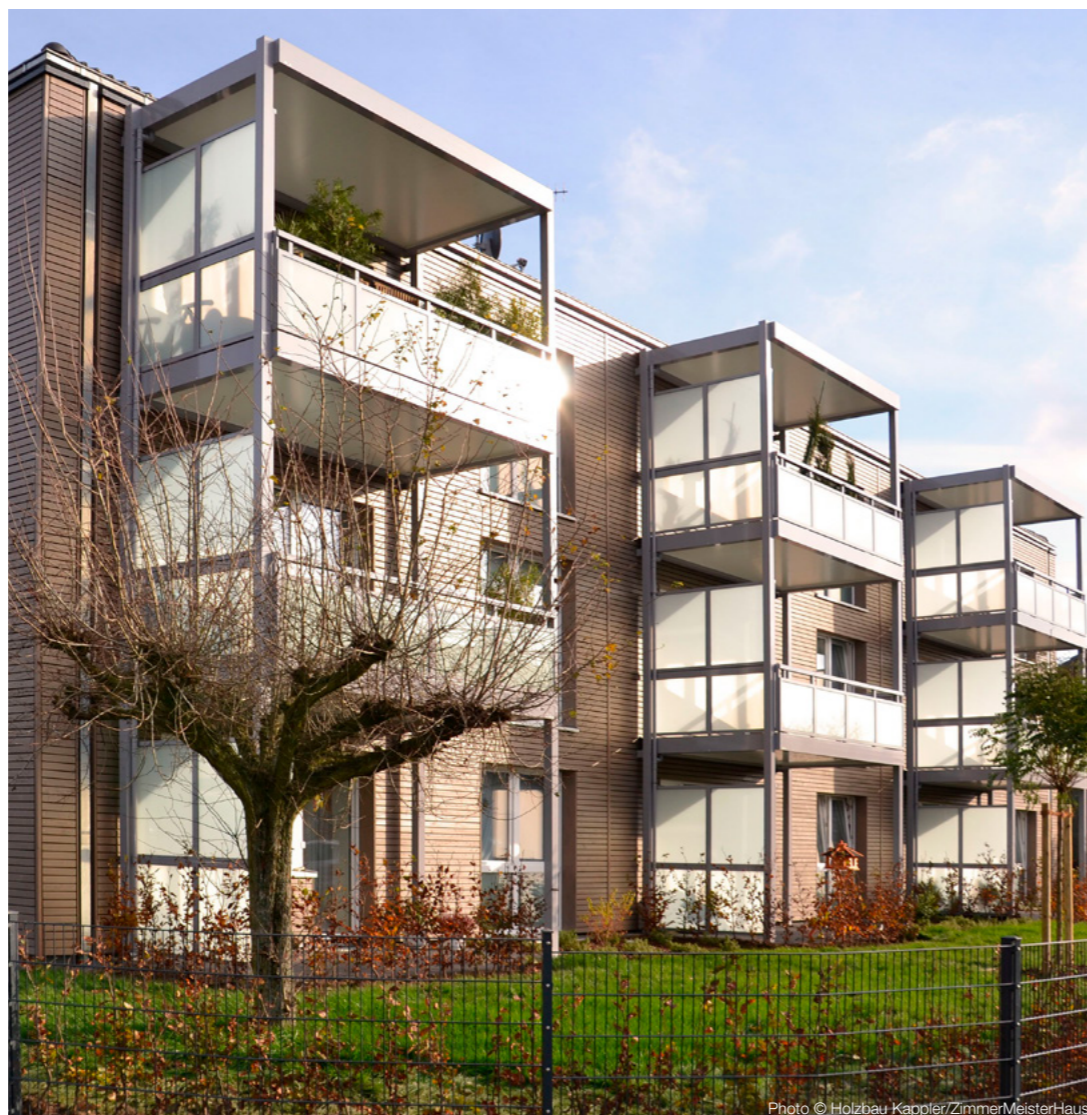
Photo © Holzbau Kappler/ZimmerMeisterHaus
