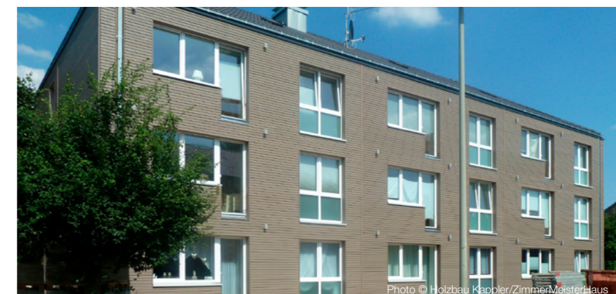
Photo © Holzbau Kappler/ZimmerMeisterHaus
