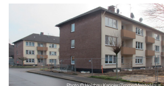
Photo © Holzbau Kappler/ZimmerMeisterHaus
