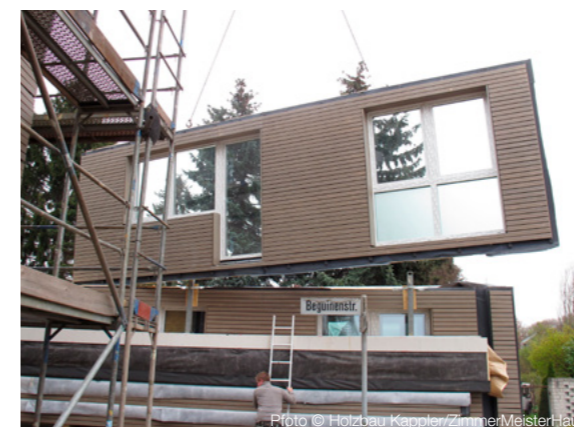
Photo © Holzbau Kappler/ZimmerMeisterHaus
