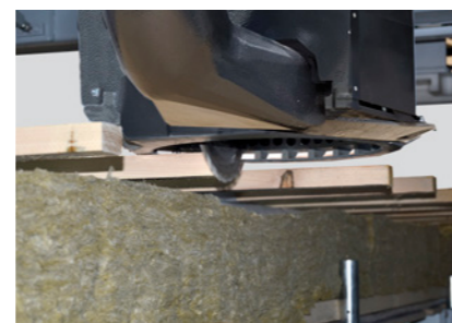
Formatieren der Dachlattung
