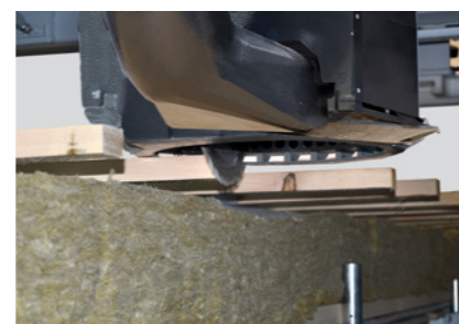
Squadratura dei listelli del tetto
