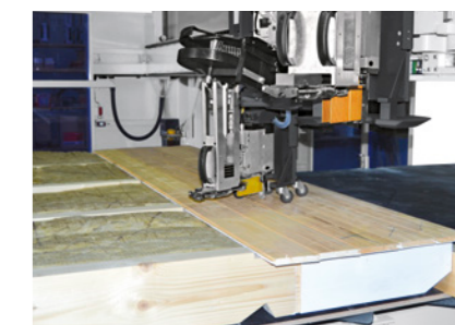
Fixation des planches de coffrage
